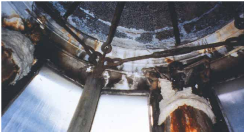
Svjetiljka svjetionika s vidljivim sustavom horizontalnoga vjetrovnog veza
